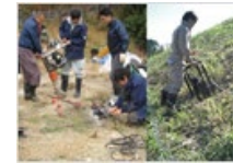
土木構造物の非破壊検査法 (小林教授)
